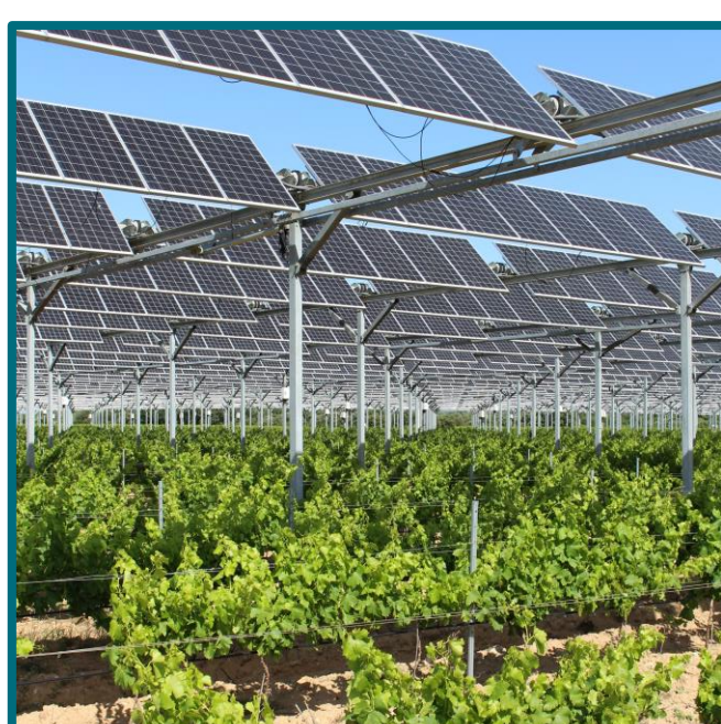
Abb. 5. APV im Weinbau in Perpignan, Frankreich (Sun' Agri). Die Firma betreibt mehrere APVs, v.a. zur Stromproduktion. Zusätzlich weinbauliche Beobachtungen: ↓Temperatur, ↓Trockenstress, ↑Aroma, ↓Spätfrost
