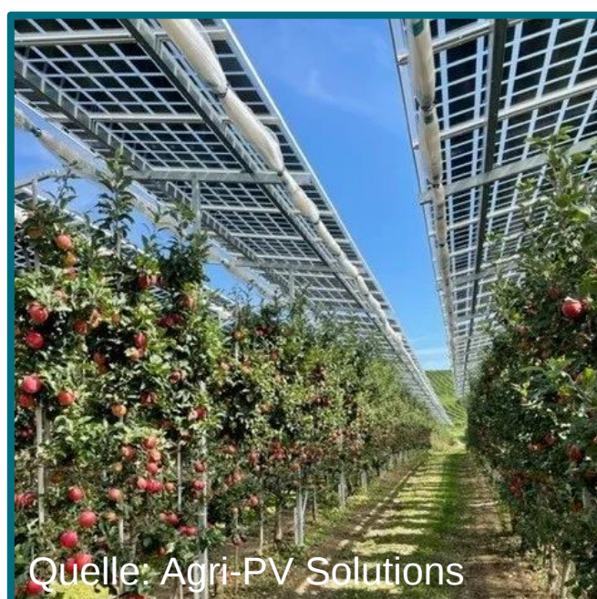
Abb. 2. Apfelanlage in Kressbronn, Deutschland. In dieser APV ersetzen die Module teilweise die Hagelschutznetze. Die PV-Paneele bieten so eine nachhaltigere Alternative zu den Netzen.
